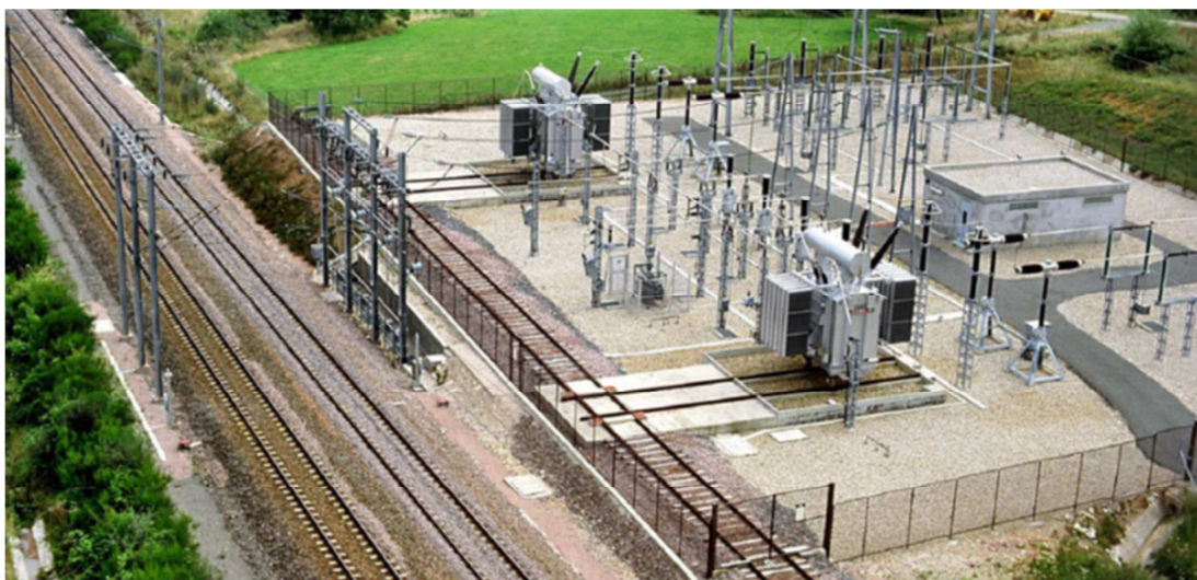
Obrázek 3: SNCF – Pochozí stezky a stanoviště trakční napájecí stanice
