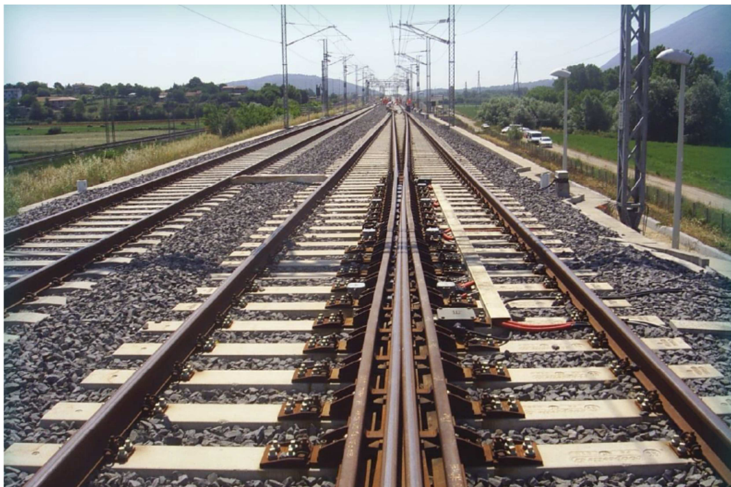
Obrázek 4: RFI – Pochozí stezky a podélná cesta
