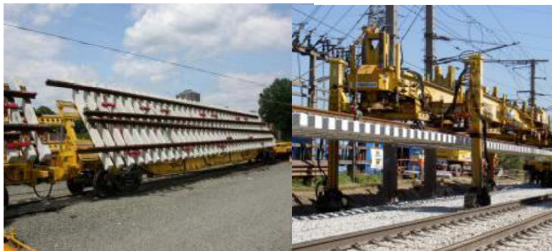
Obrázky 1 a 2: Převážka smontované části výhybky a její pokládání
